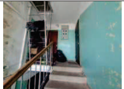
2.stāva kāpņu telpa
