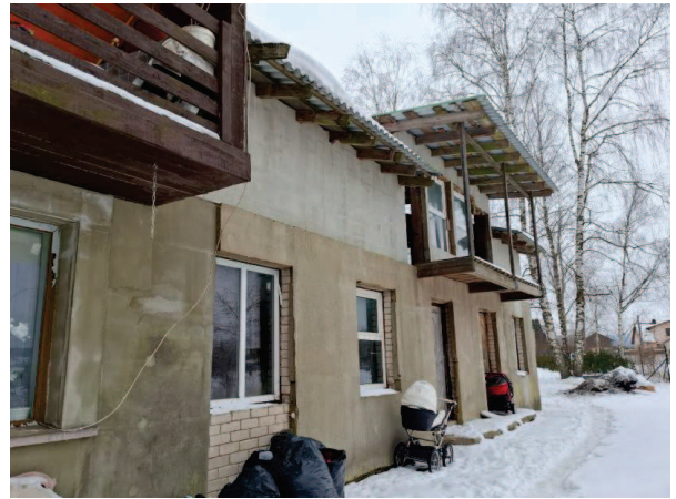
Būvniecības stadijā esošā ēkas daļa
