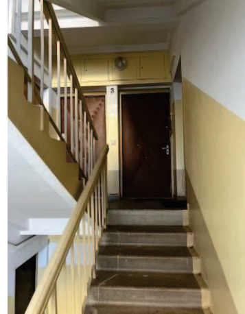
Kāpņu telpa 3.stāvā
