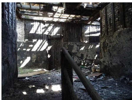
Ēkas 2. stāva iekšskati
