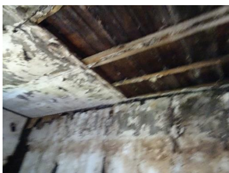
Ēkas 2. stāva iekšskati
