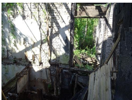
Ēkas 1. stāva iekšskati
