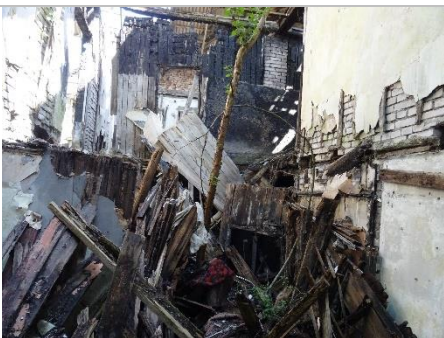
Ēkas 1. stāva iekšskati
