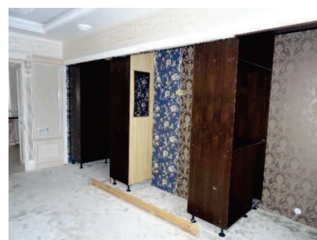
Dzīvojamā istaba (telpa Nr. 6) – daļēji demontētas iebūvējamās mēbeles
