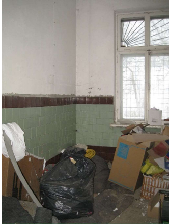
Ražošanas ēkas 1.stāva telpa
