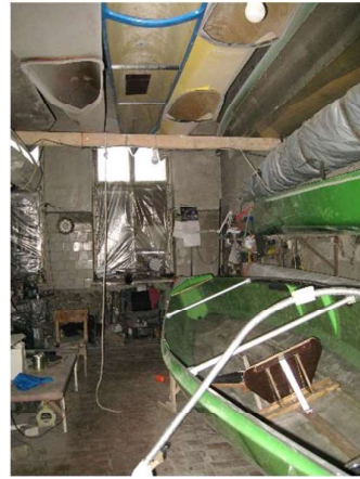
Ražošanas ēkas 1.stāva telpa
