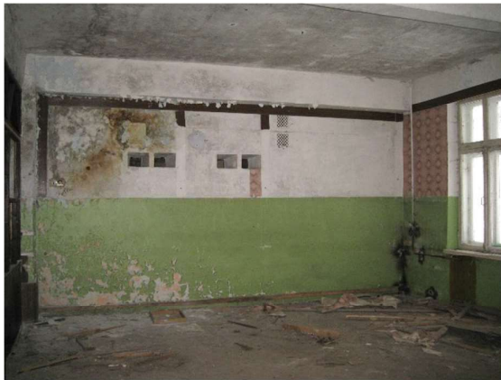
Administratīvās ēkas 1.stāva telpa
