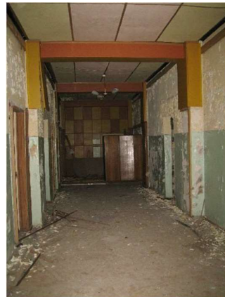
Administratīvās ēkas 2.stāva telpa
