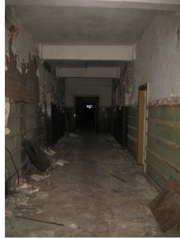
Administratīvās ēkas 1.stāva telpa
