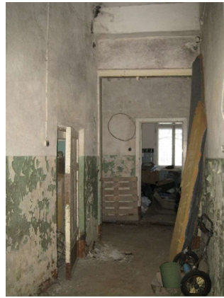
Ražošanas ēkas 1.stāva telpa
