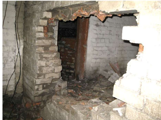
Ražošanas ēkas un katlu mājas 1.stāva telpas
