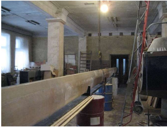
Ražošanas ēkas 1.stāva telpa
