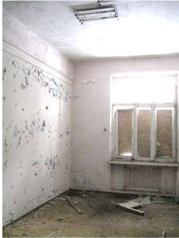
Administratīvās ēkas 1.stāva telpa
