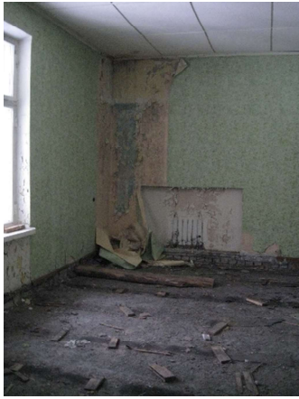
Administratīvās ēkas 2.stāva telpa
