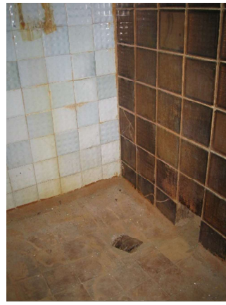
Administratīvās ēkas 1.stāva telpa
