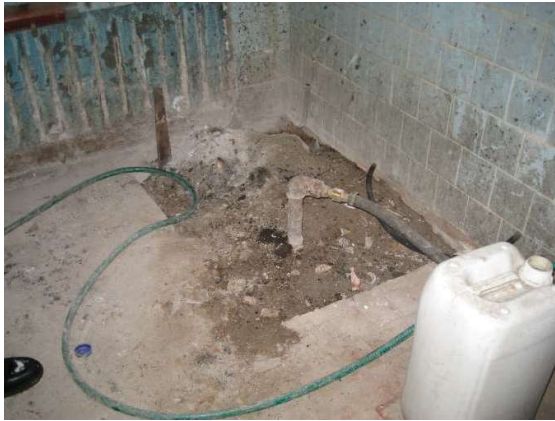
Ražošanas ēkas 1.stāva telpa
