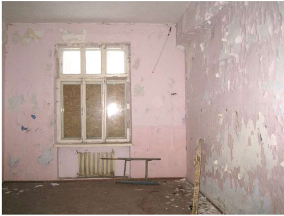
Administratīvās ēkas 1.stāva telpa
