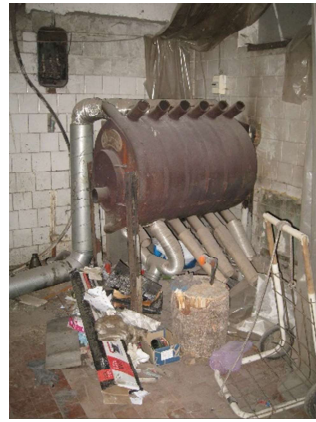
Ražošanas ēkas 1.stāva telpa
