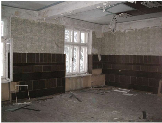
Administratīvās ēkas 2.stāva telpa
