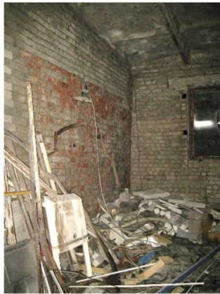
katlu mājas 1.stāva telpa
