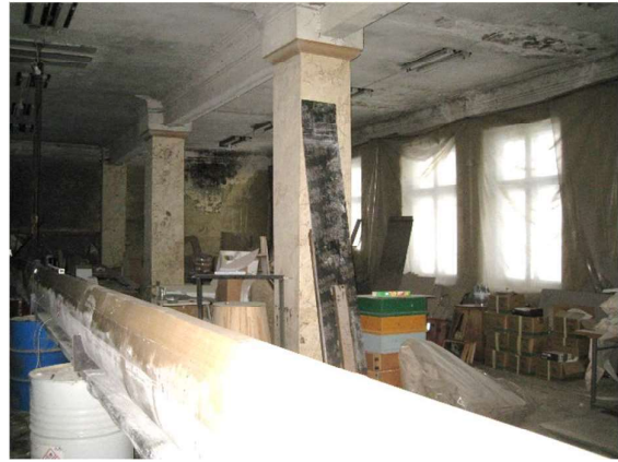
Ražošanas ēkas 1.stāva telpa
