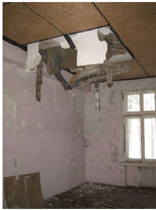
Administratīvās ēkas 2.stāva telpa
