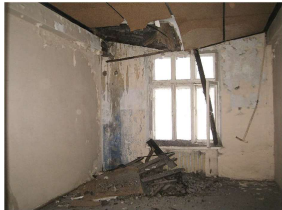
Administratīvās ēkas 2.stāva telpa
