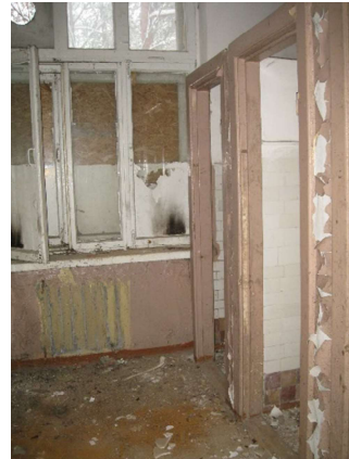
Administratīvās ēkas 1.stāva telpa
