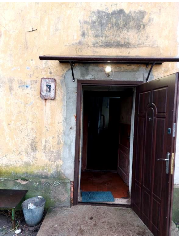
Skats uz kāpņu telpas durvīm
