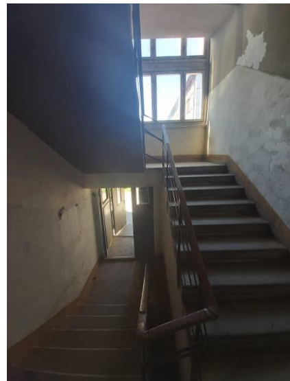
Mājas kāpņu telpa
