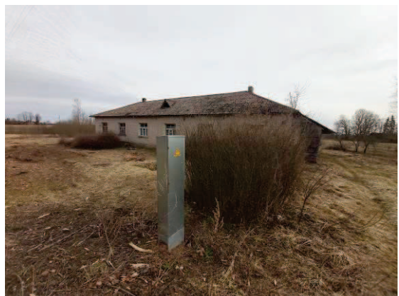
Elektrības sadalnes skapis
