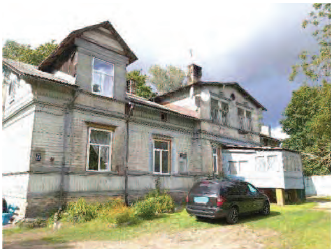
Dzīvojamās ēkas galvenās fasādes daļa (skats no kreisās puses)
