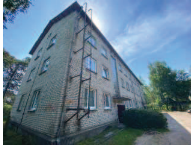
Dzīvojamās ēkas fasādes daļa no pagalma
